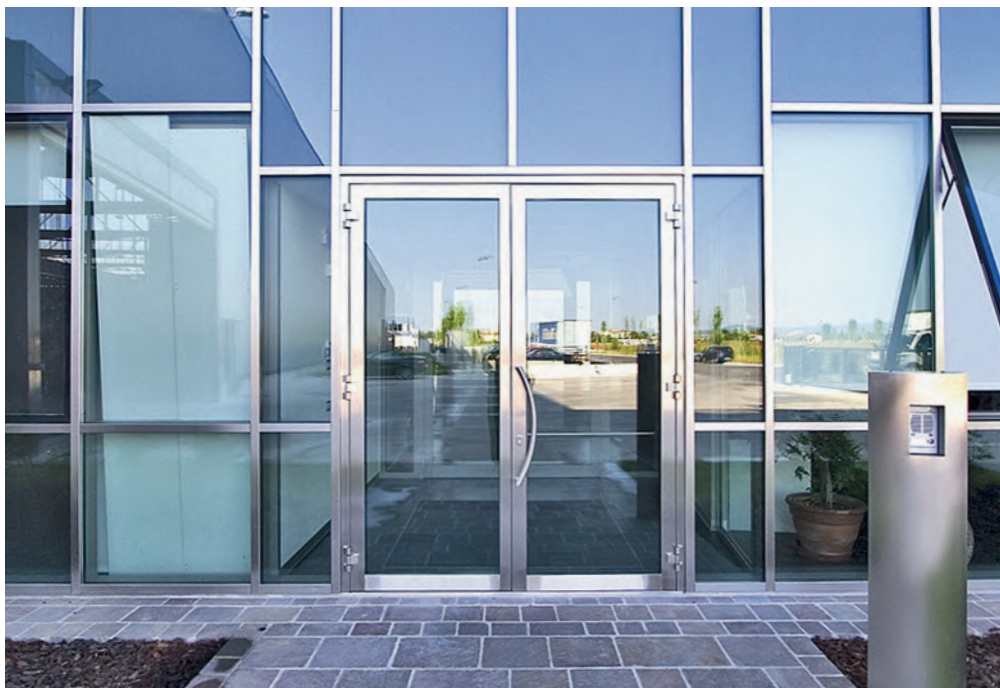
Abb.77: Eingangsbereich mit WICONA Tür
