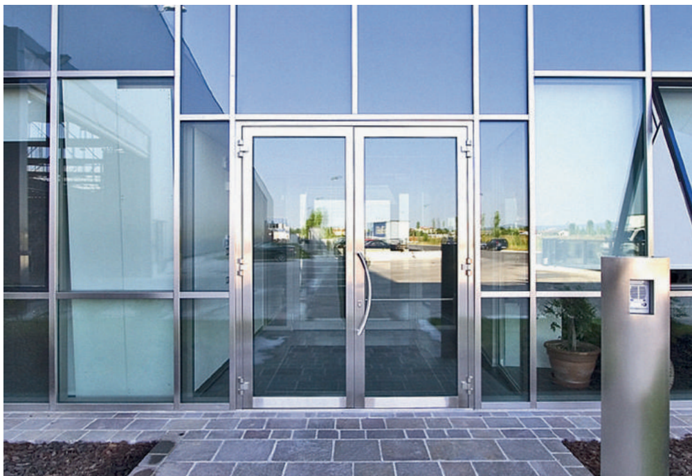
Abb.77:Eingangsbereich mit WICONA Tür
